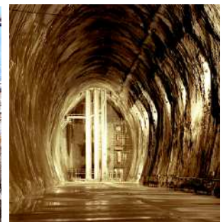
地下岩盤タンク
