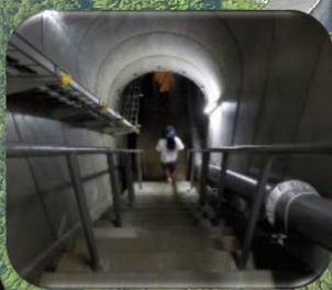
ダム堤体内部
