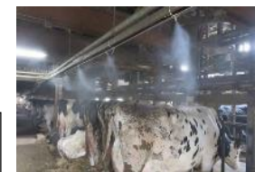
超微粒子の霧で周囲を濡らすことなく、気化熱で温度を下げる
