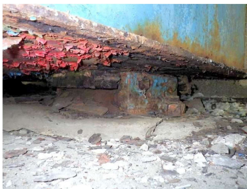
凍結抑制剤による損傷事例(主桁端部)
