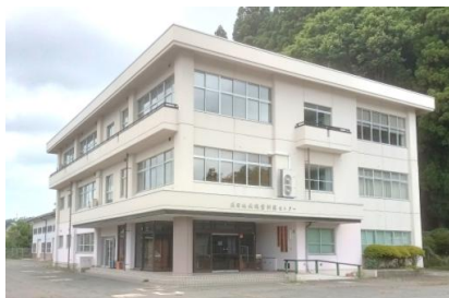
旧盛岡地域職業訓練センター （加賀野四丁目18-50） ※2025年3月閉館
