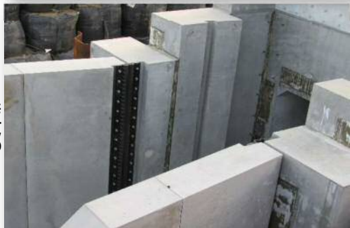
胸壁 と翼壁 接続部
