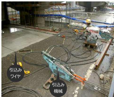
8. BOX移動(横引き工法) 引込み機械 (チルホール 3t用)
