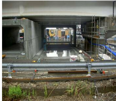
7. BOX移動(横引き工法)
