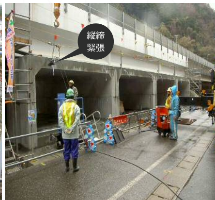
9. 縦締緊張工 (アンボンドPC鋼より線)
