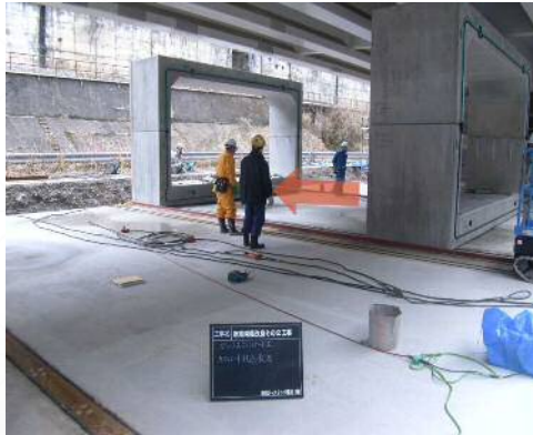
7. BOX移動(横引き工法)
