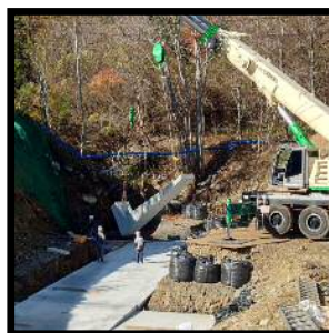
擁壁荷降ろし、起上げ状況
