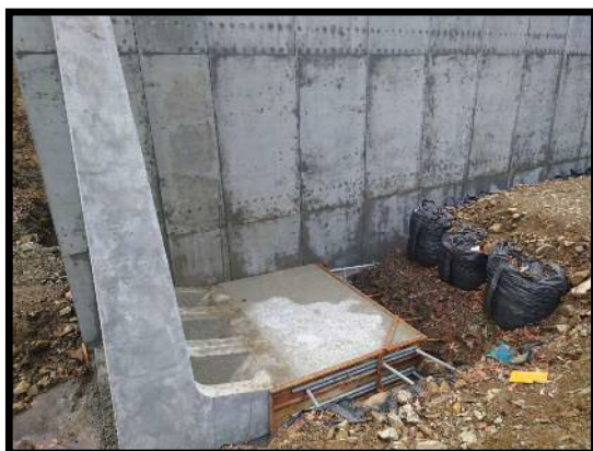
底版コンクリート打設後
