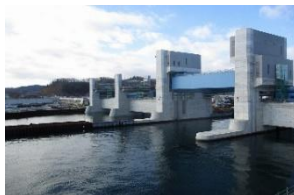
整備中の関伊川水門（宮古市）
