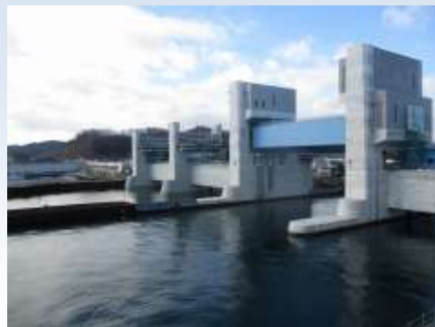
整備を進めている閉伊川水門（宮古市）
